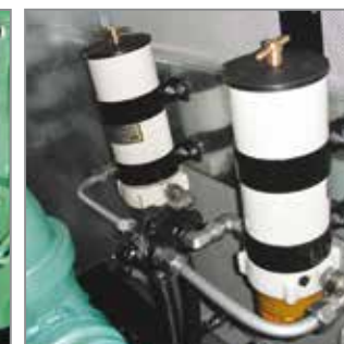
▲ TWIN water separator filter DOUBLE filtre séparateur eau
