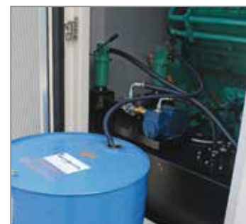
▲ Electric oil refilling/emptying pump Pompe électrique de remplissage et vidange pour l'huile
