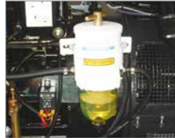
▲ Water separator filter Racor type Filtre séparateur eau type Racor
