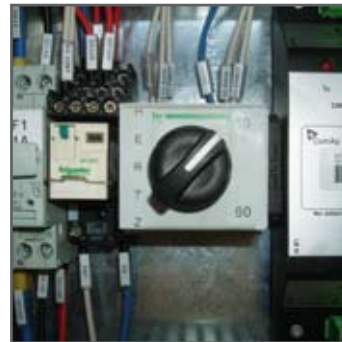
▲ 50-60Hz switch for DUAL frequency Commutateur 50-60Hz pour DOUBLE FREQUENCE
