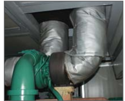
4 Well insulated exhaust silencer Silencieux d'échappement bien isolé
