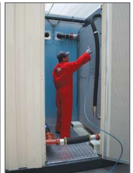
▲ Easy access to radiator for cleaning and visual checks Accès facile au radiateur pour nettoyage et contrôles visuels
