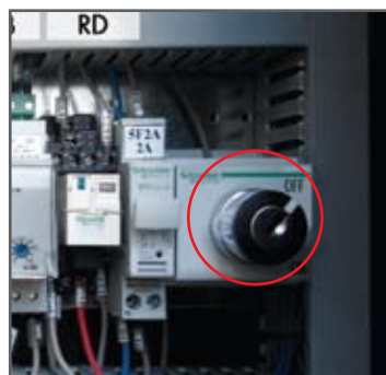
▲ ELCB ON/OFF switch Interrupteur désactivation protection différentielle
