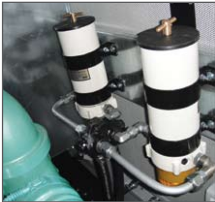
▲ TWIN water separator filter DOUBLE filtre séparateur eau
