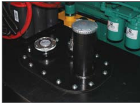
▲ Mechanical fuel level reading placed next to the filling point Lecture mécanique niveau carburant placé à côté du point de remplissage
