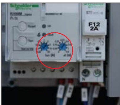
▲ Adjustable ELCB Protection différentielle réglable
