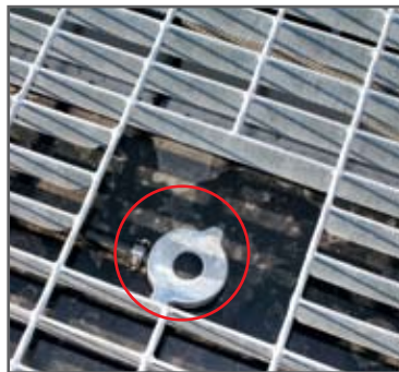
4 External radiator topping point Point de remplissage radiateur externe
