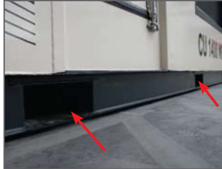
▲ Container with forklift guides Container avec supports pour fourches
