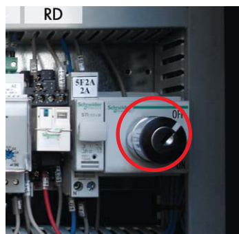
▲ ELCB ON/OFF key switch Interrupteur désactivation protection différentielle
