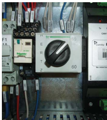
▲ 50-60 Hz switch Commutateur 50/60 Hz
