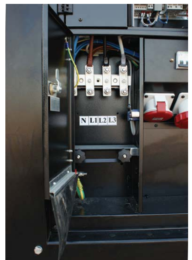
▲ Distribution board with sockets kit and power busbar Coffret de distribution avec plastron prises et bornier de puissance
