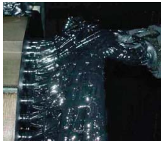
▲ Alternator butadienic protective treatment Traitement de protection de l'alternateur au butadiène
