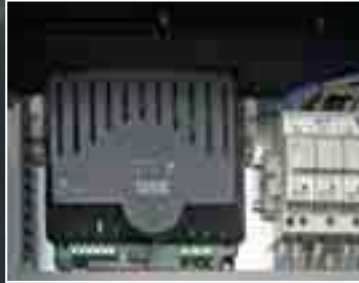
Battery charger 220-240V Chargeur de batterie 220-240V
