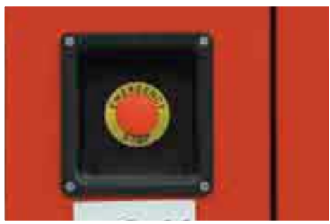
Emergency stop button placed on the outside of the control panel Bouton d'arrêt d'urgence placé à l'extérieur du coffret
