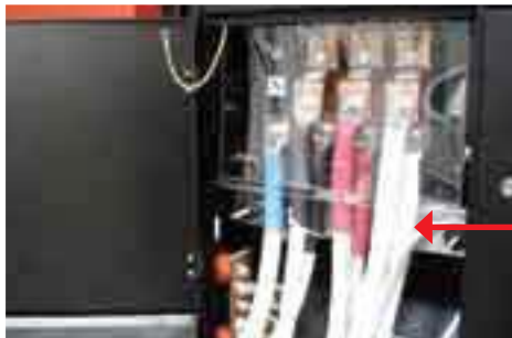
⦿ Power terminal board for synchronization with the mains Bornière pour parallélisme avec le secteur
