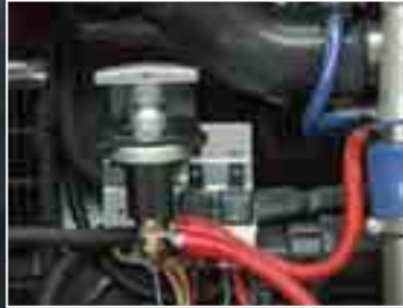
Battery isolator switch Interrupteur coupe-batterie
