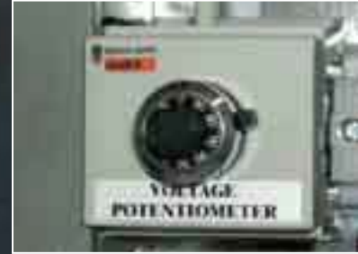
Voltage potentiometer Potentiomètre de tension
