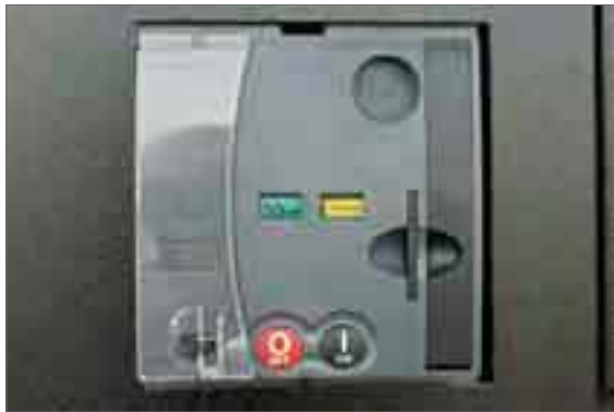
⦿ Motorized circuit breaker for synchronization of generating sets Disjoncteur de protection motorisé pour la synchronisation entre les groupes électrogènes
