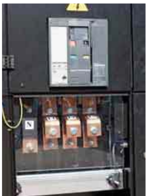
Power terminal board protection Protection bornière de puissance
